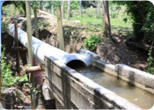
Rehabilitación de unidad de riego, La Palma Zacapa.
