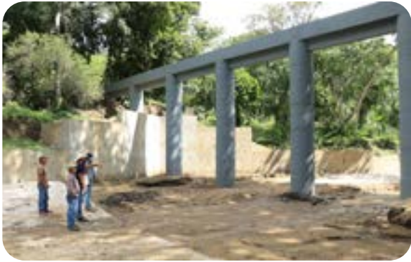
Reconstrucción de cunetas de sistema de riego La Palma, Zacapa
