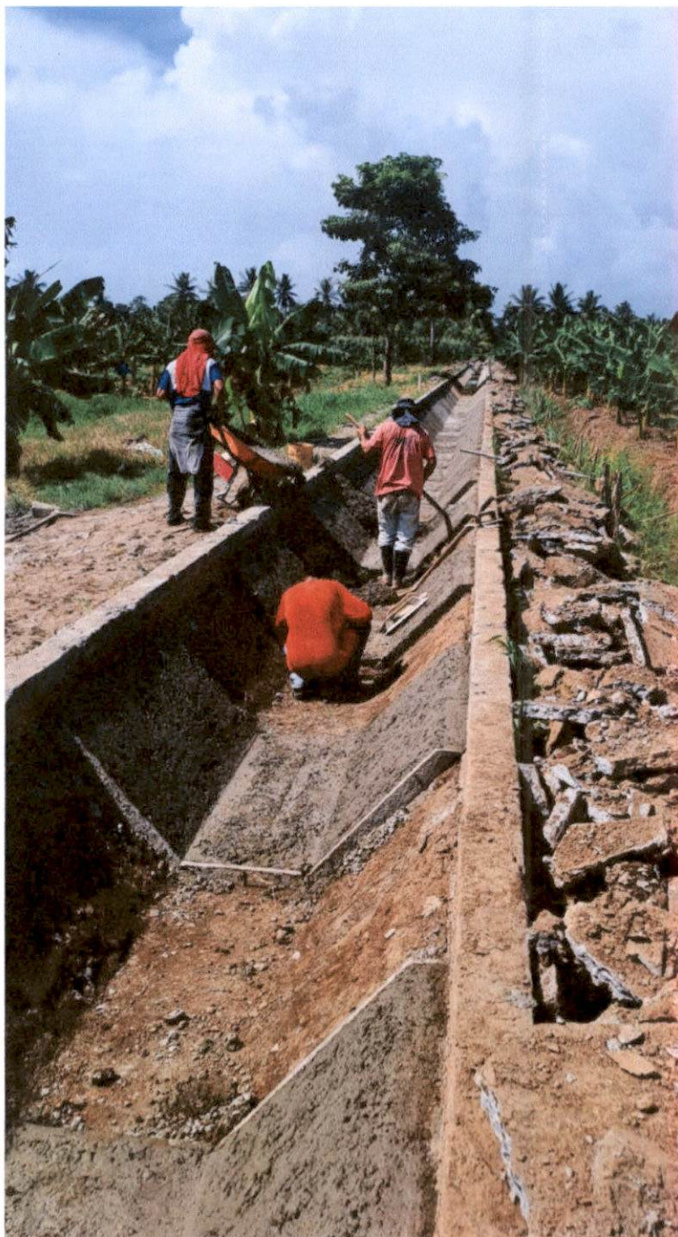
Canal secundario dos: Fundición de pisos y pizarras nuevas en el canal secundario dos.
