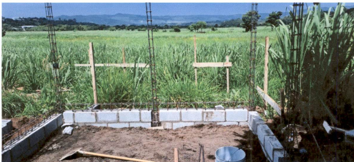
Construcción de caseta de bombeo para línea de conducción.
