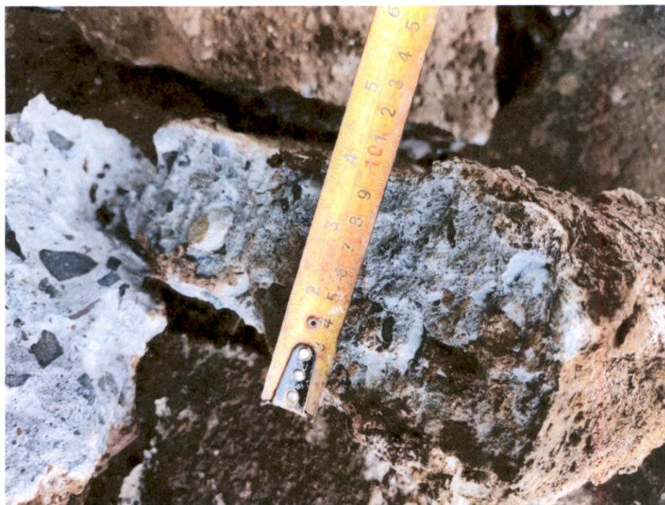
Canal central: Continuación de la demolición de las pizarras y pisos viejos para el mejoramiento del canal central, espesor 10 cm de demolición.
