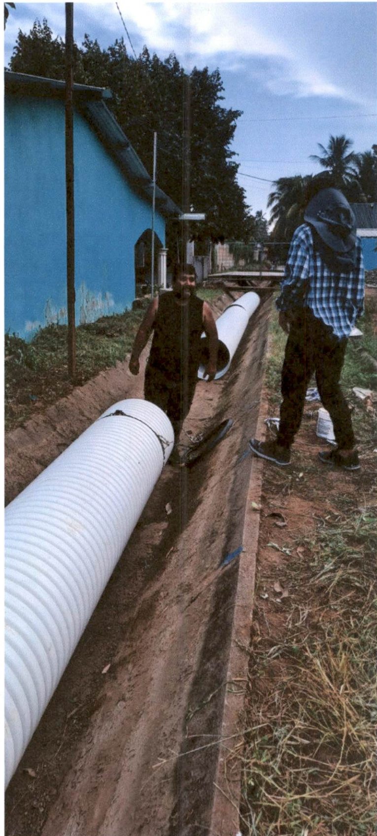
Suministro e instalación de tubería de PVC de 24" Norma AASTO M-304
