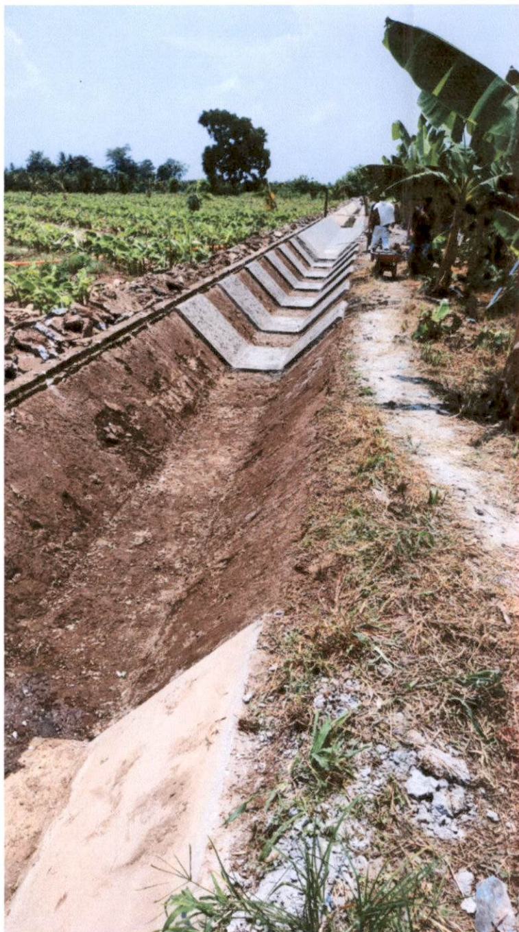
Canal secundario dos: Demolición de los pisos y pizarras viejos en el canal secundario dos.
