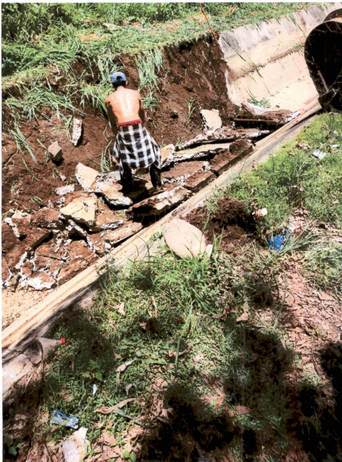
Canal central: Continuación de la demolición de las pizarras y pisos viejos para el mejoramiento del canal central.
