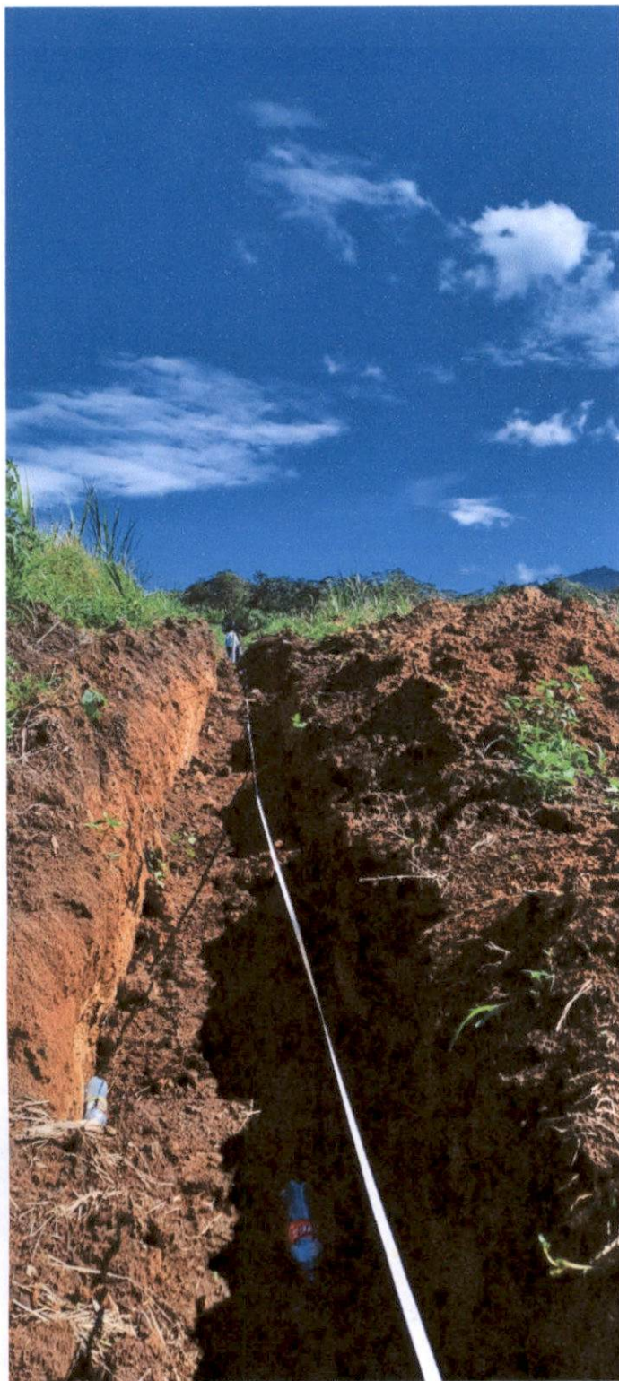
Instalación de línea de bombeo 1,310 metros lineales instalados.
