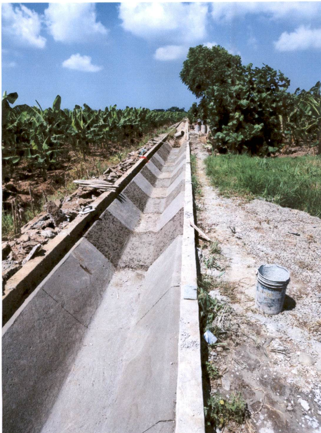
Canal secundario dos: Fundición de pisos y pizarras nuevas en el canal secundario dos.
