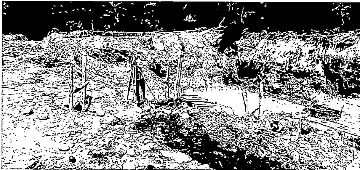
Fotografía: trabajos de replanteo topográfico.
