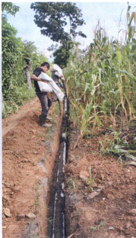
Reglón de relleno en las líneas de conducción.
