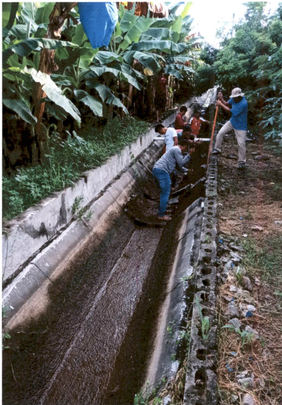
Canal secundario dos: Demolición de los pisos y pizarras viejos en el canal secundario dos.
