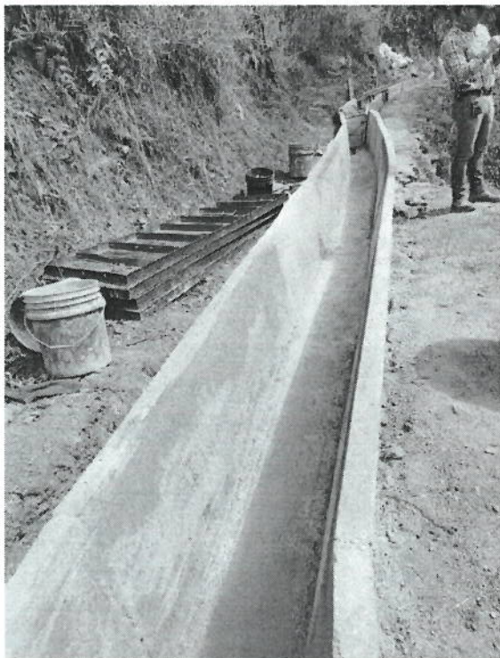
Construcción De Canal Principal Rectangular Con Concreto Reforzado En La Sierra De Las Minas
